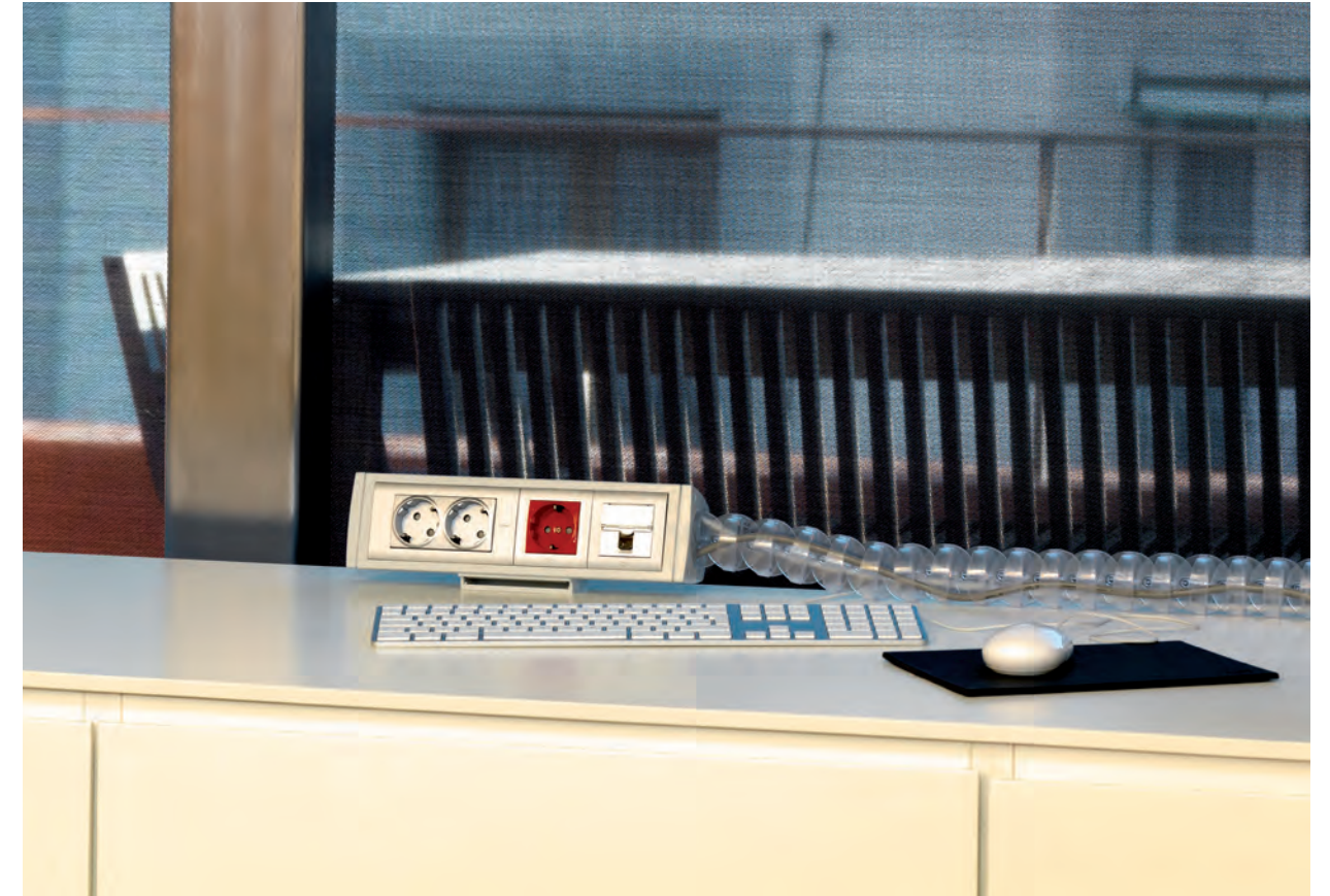
Puesto de trabajo: oficina
