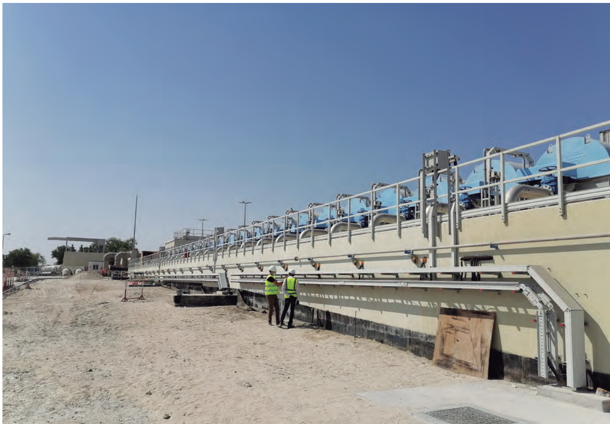
Tratamiento de aguas: EDAR
