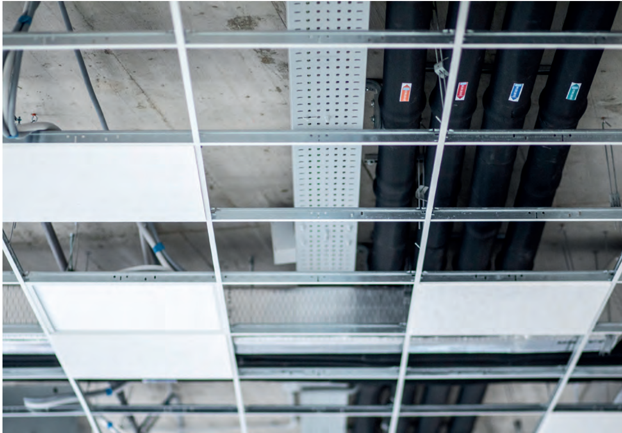
Espacio de trabajo: oficina
