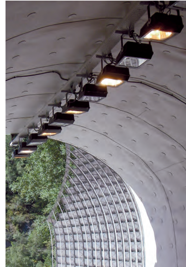
Infraestructura viaria: túnel
