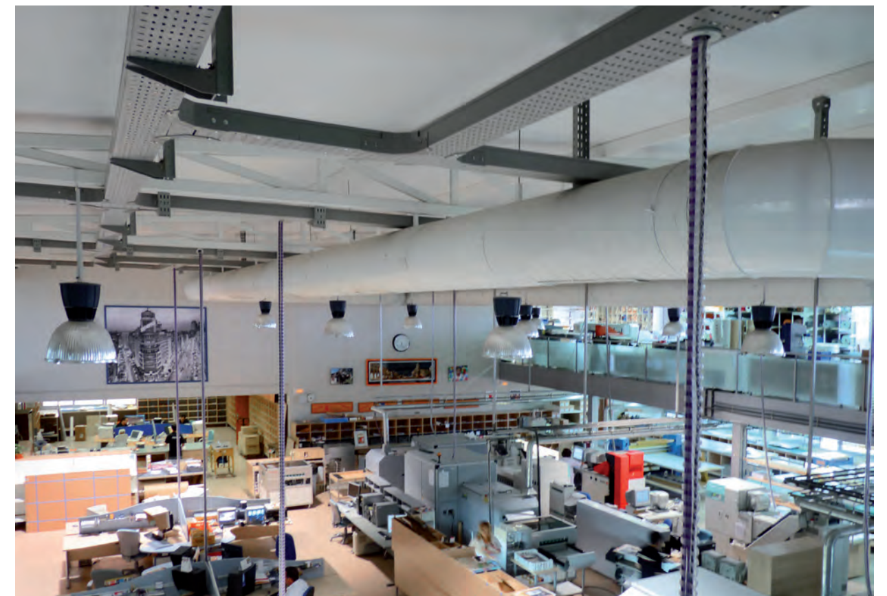
Nave industrial: oficina
