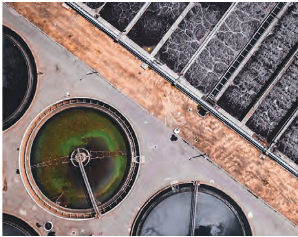
Tratamiento de aguas
