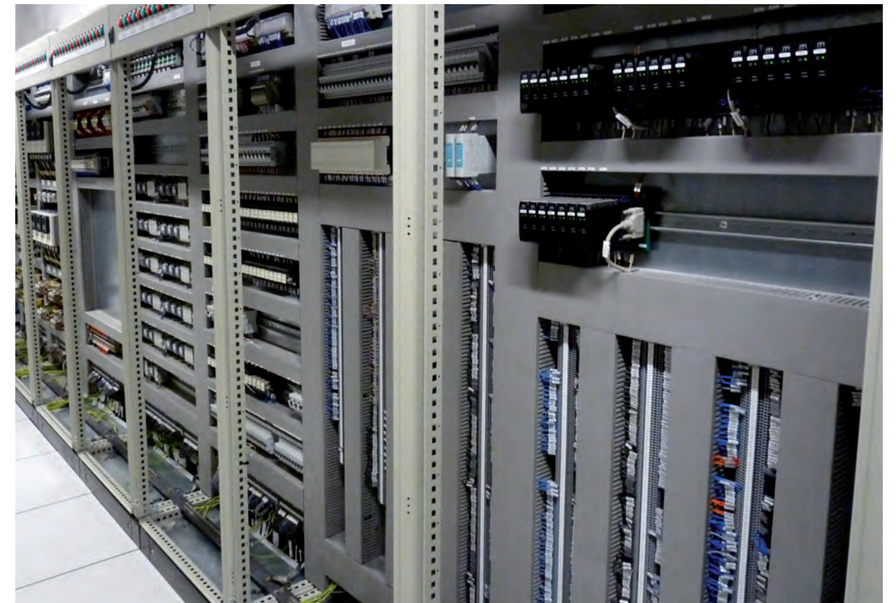
Tratamiento de aguas
