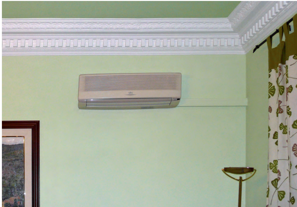
Rehabilitación de viviendas
