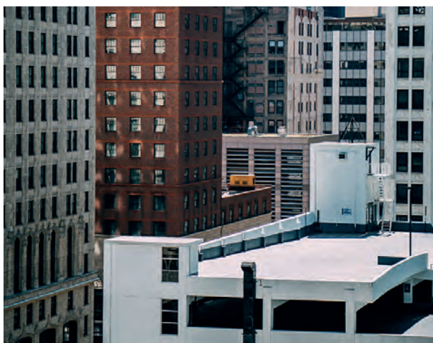
Instalaciones en azoteas
