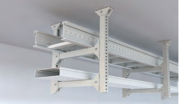
Pórtico a pared desde techo
