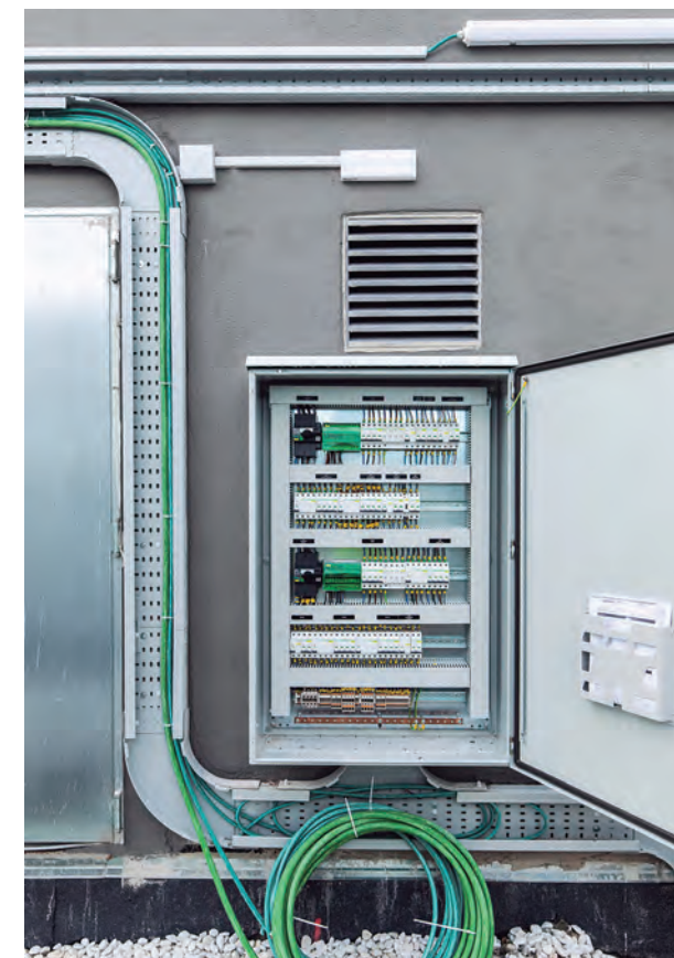
Espacio de trabajo: oficina
