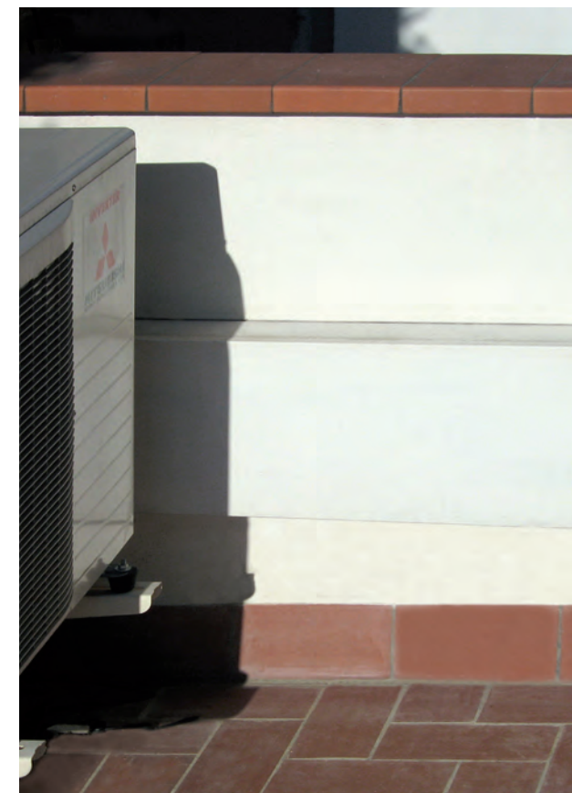
Rehabilitación de viviendas
