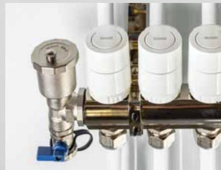
El termostato controla también actuadores de válvula (230 voltios) montados en el distribuidor de circuitos de calefacción.
