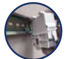
Ejemplo de fijación en carril DIN
