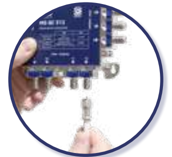
Conversión a conector F mediante adaptador AQC F
