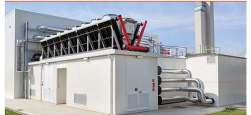
El laboratorio puede probar unidades con capacidades de refrigeración de hasta 1,5 MW, con gran precisión en una amplia gama de condiciones de trabajo, desde -10°C hasta +55°C, incluso para unidades adiabáticas.
